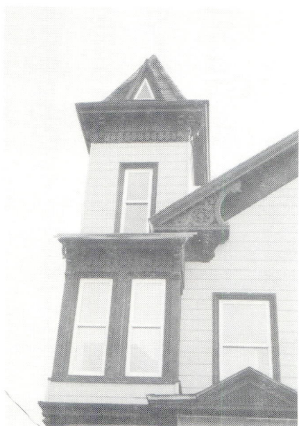
D18. Corner tower
