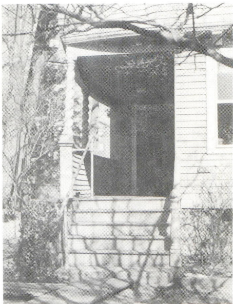
F2. A twisted-column porch
